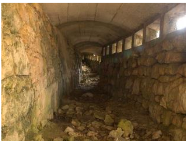
Ponte delle Lastre, l'interno della fortificazione.
